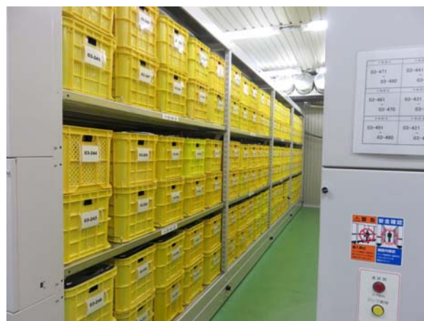
写真－2 第 2 冷凍室内の様子
