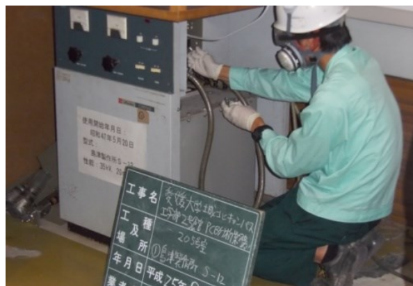
写真 6 島津 X 線回折装置用トランス①
