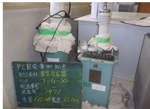
写真 2 粗大ごみ回収時に発見した PCB 廃棄物
