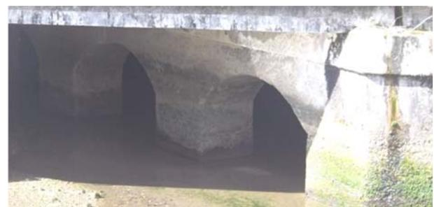
写真-3 壁式アーチ構造の橋脚
